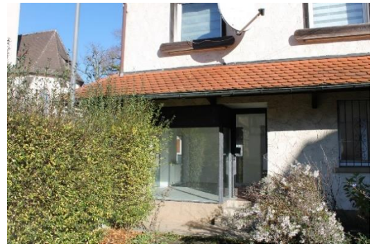
Abbildung 20: Weite Straße, Leerstand Gewerbeeinheit im Erdgeschoss (Quelle: WHS, 2022)
