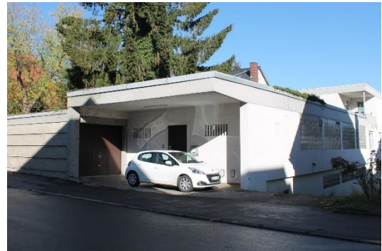
Abbildung 18: Hirschstraße, Gebäude mit Modernisierungsbedarf (Quelle: WHS, 2022)
