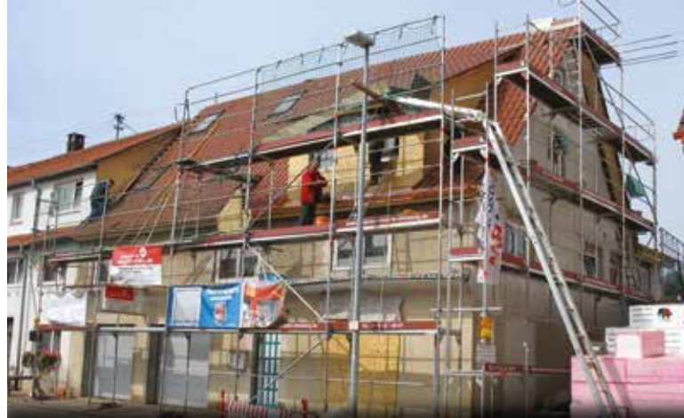
Beispiel: Erneuerung Fassade/Dachstuhl
