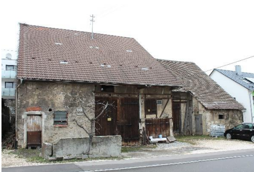
Abbildung 3: Pfeiferstraße 1 und 3, Gebäude mit substanziellen Mängeln (Quelle WHS, 2020)
