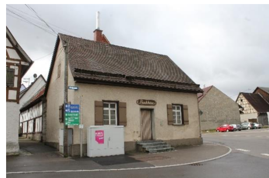
Abbildung 4: Weite Straße 42, Gebäude mit erheblichen Mängeln (Quelle WHS, 2020)
